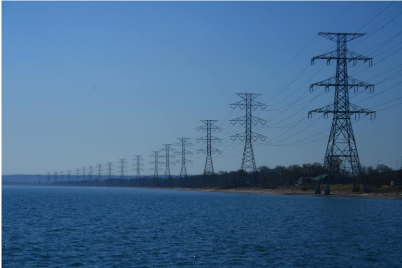
1.21 | Lake Side Powerlines
