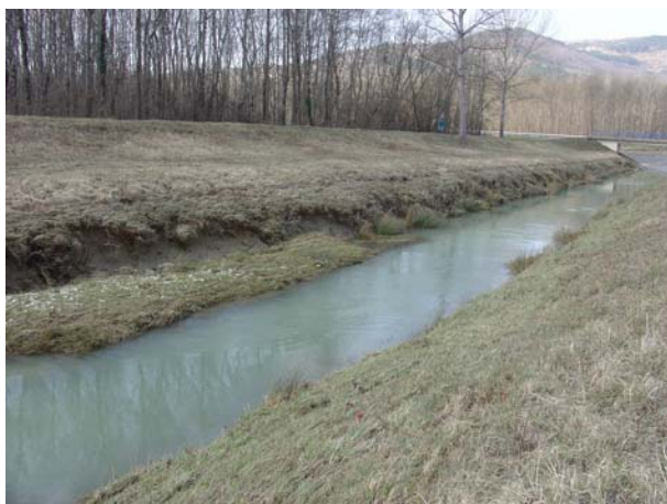
Slika 11. Nizvodni dio kanala nakon zatvaranja zapornice
