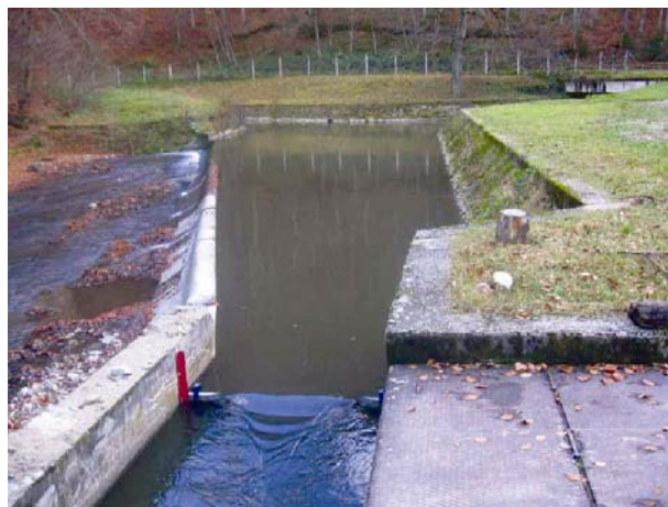
Slika 4. Vodozahvat na rijeci Pakri
