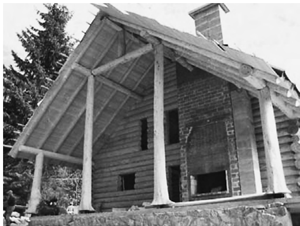
Slika 4. Drvena kuća od trupaca „Woodmar“, Maksim Stella, d.o.o., Koprivnica Figure 4 Timber house „Woodmar“, Maksim Stella, d.o.o., Koprivnica
