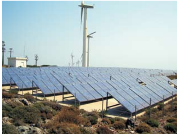
Slika 1 — Pogled na FN park C. Rokas SA — FN moduli nagnuti su 30°, orijentirani prema jugu (u pozadini susjedna vjetroelektrana)
