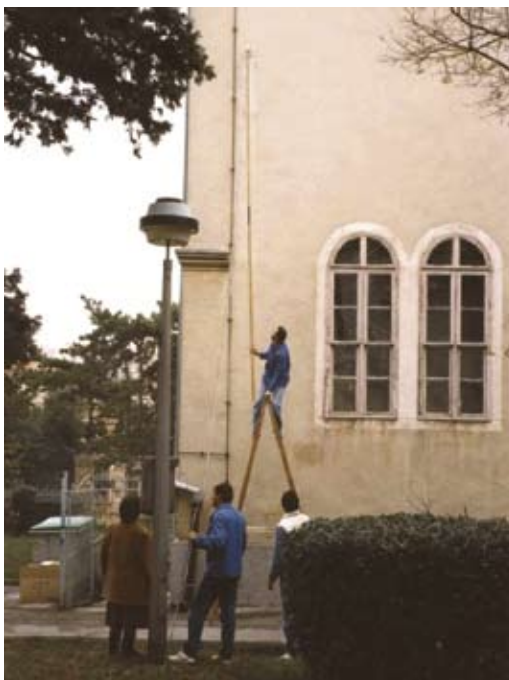
Marljivi i predani bolnički radnici postavljaju svjetlovodni kabel 1995. g.
