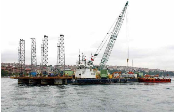
Slika 6. Postupak zbijanja injektiranjem u istanbulskom tjesnacu
