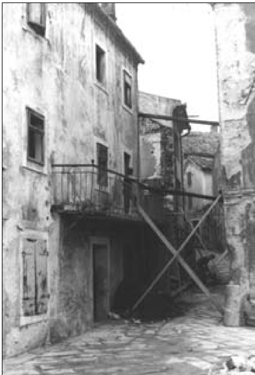
Sl. 4. Sanacija ruševina i učvršćenje oštećenih objekata poslije jednog od bombardiranja. Na fotografiji se vidi dio današnje Ulice Petra Preradovića, snimio Ivan Stella st.
