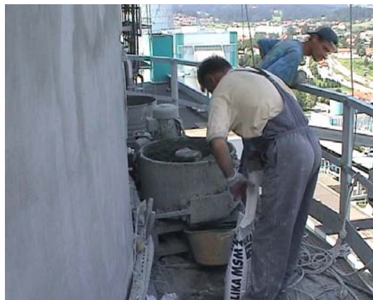
Slika 5. Miješanje morta s dodatkom polimera s maksimalnim zrnom do 2 mm
