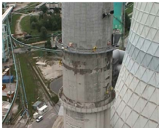
Slika 6. Prikaz tehnoloških resursa pri sanaciji betona plašta dimnjaka
