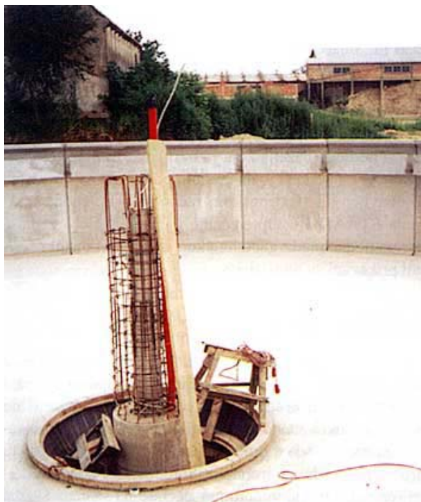
Slika 4. Detalj taložnika tijekom gradnje
