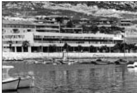
SL. 14. ZGRADA „POMORSKE PRIVREDE”, SPLIT, 1963. (NAGRADA „VIKTOR KOVAČIĆ”)
