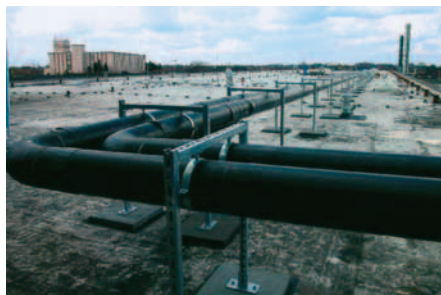
SLIKA 5. Predizolirani cijevni sustav Cool-FIT -a
