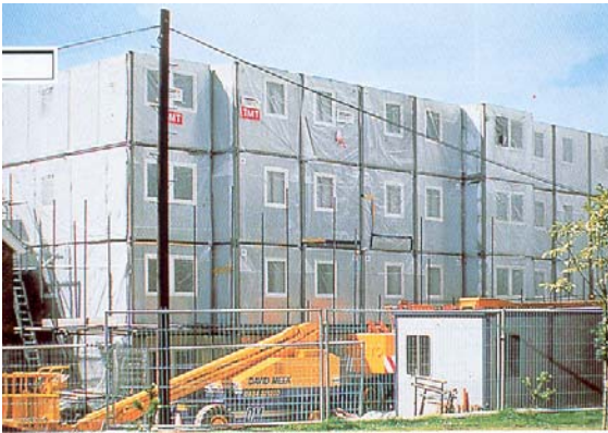
Slika 23. Montaža modula
