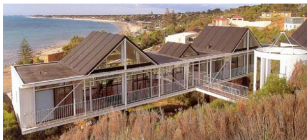
Slika 21. Izgled dogotovljene kuće
