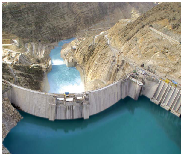
Slika 3. Lučna brana Karun 3, visine 205 m, na istoimenoj rijeci u Iranu
