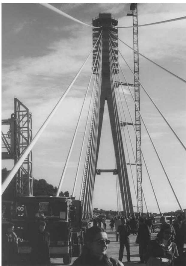
Sl. 2. Na gradilištu mosta Rijeka Dubrovačka
