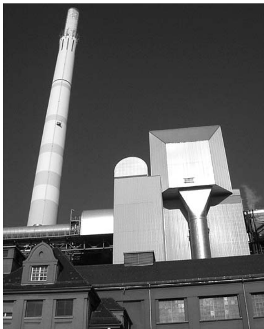
Slika 2 Spalionica komunalnog otpada u Stuttgartu
