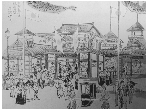
写真4 シカゴ・コロンブス万国博覧会の日本館正面 24)
