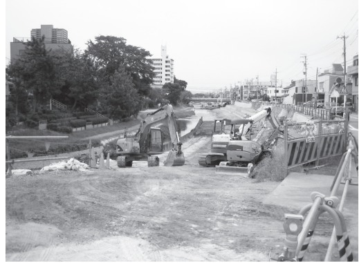
写真1 中橋から下流の地域の工事現場 (2010.8.17撮影)
