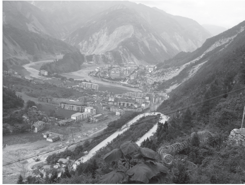
図3 北川县城の被災状況
