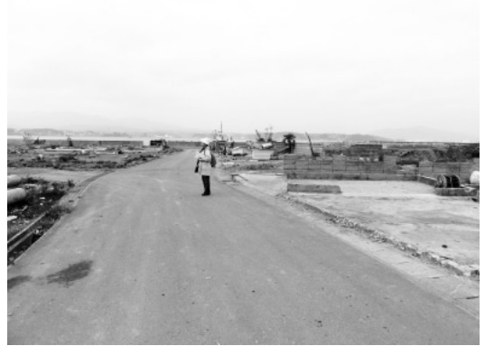
写真27：大島の田尻地区、損壊した家々が撤去された空間
