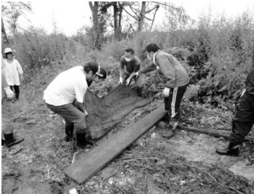
写真18：流されてきた木材やゴミの撤去作業
