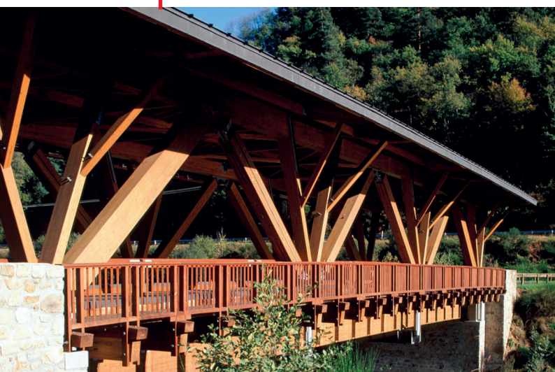
Pont couvert sur la Dore à Saint-Gervais sous Meymont.
