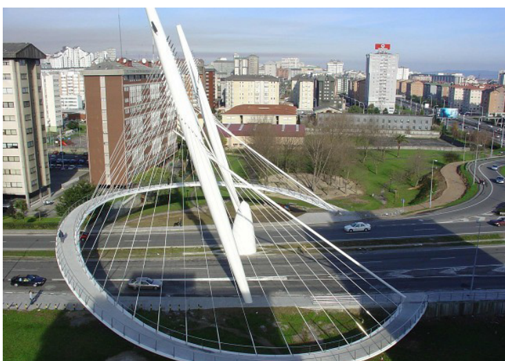
117. La Rosa Footbridge, Antonio González Serrano, La Coruña, 2003
