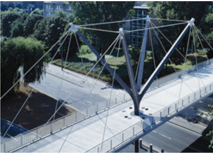
155. Marble footbridge, Jorg Schlaich, Bad Homburg von der Höhe (DE), 2002
