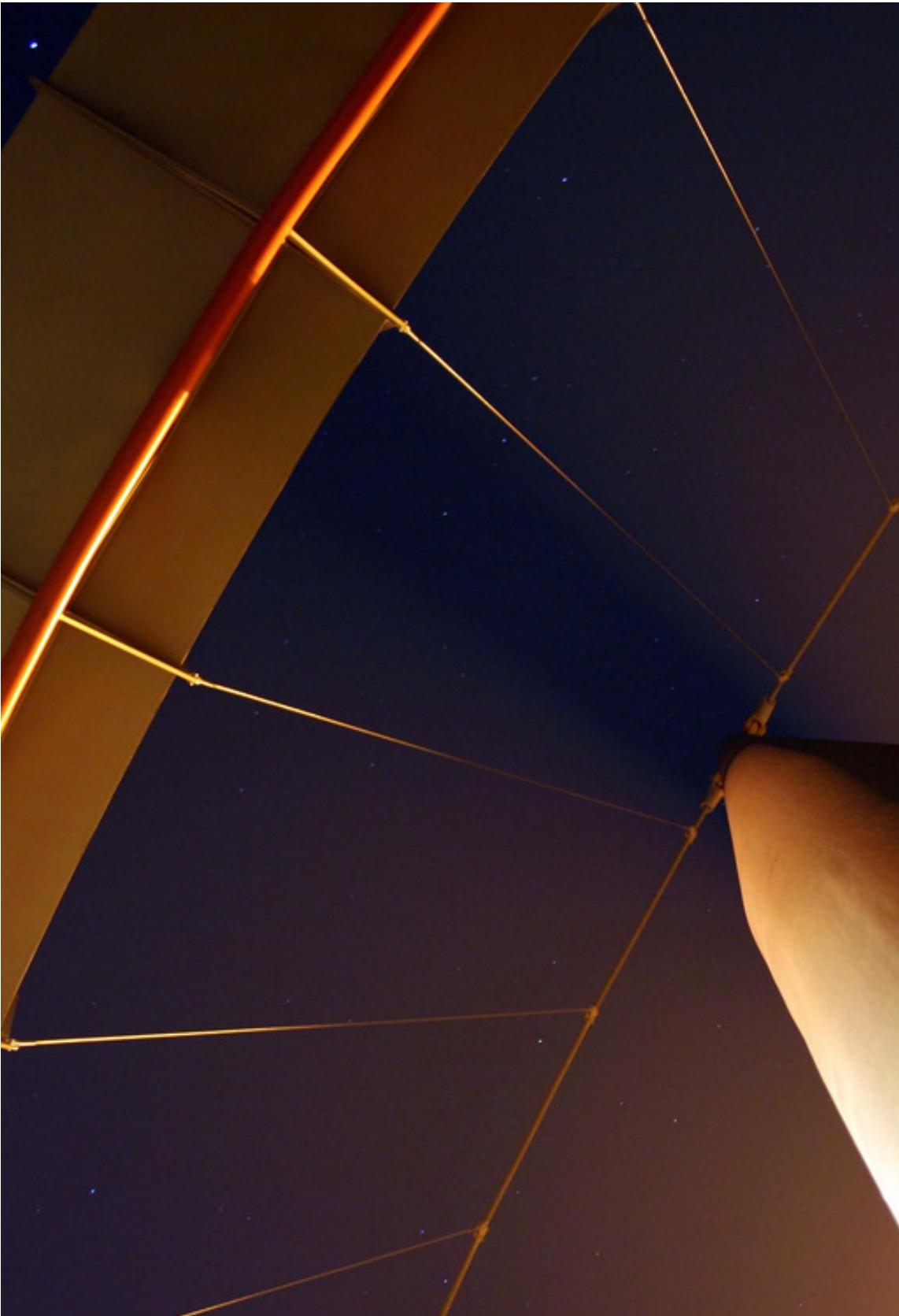
161. Sassnitz Bridge, Schlaich Bergemann und Partner, Sassnitz, 2007
