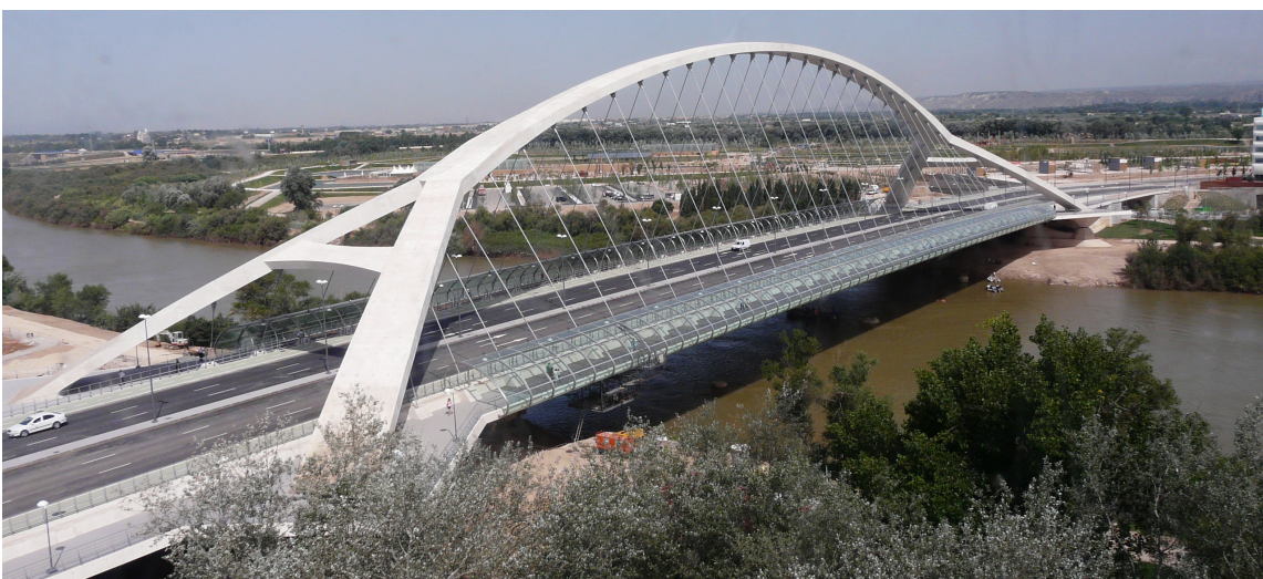
188. Puente del Tercer Milenio, Juan José Arenas, Zaragoza, 2008
