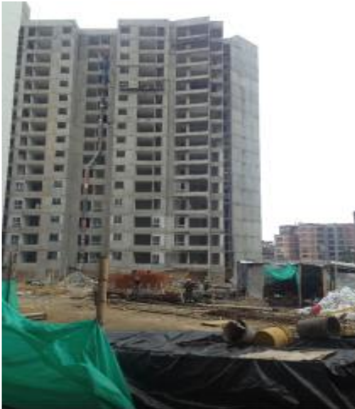
Figura 26. Vista general apartamentos obra E2
