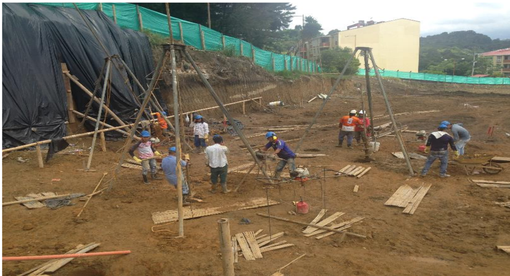
Figura 30. Aspecto general de la obra
