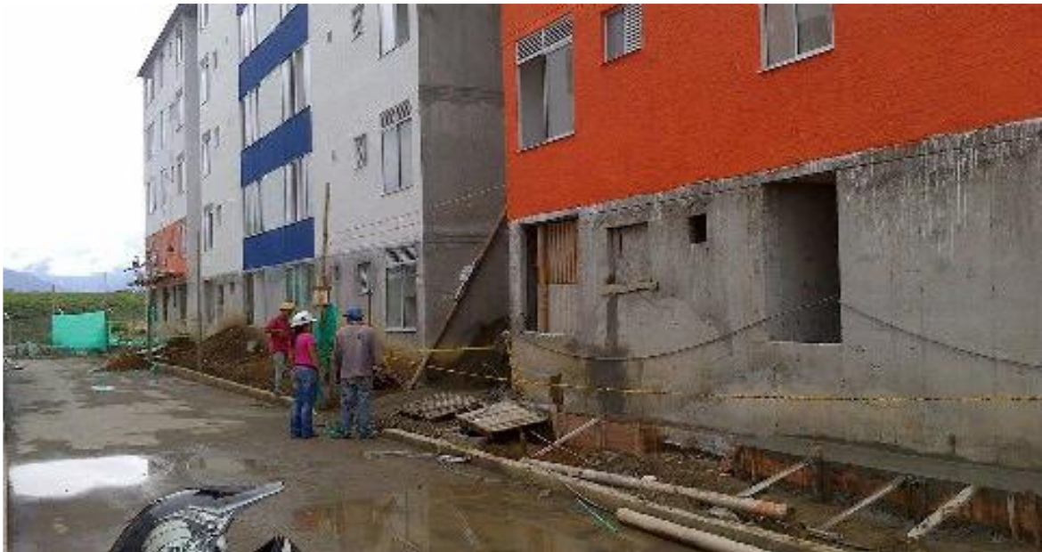
Figura 37. Vista general de la obra E4O2
