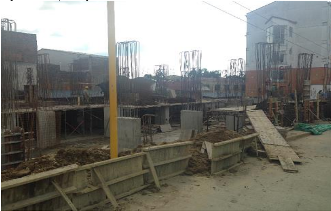
Figura 42. Aspecto general Obra E5O2
