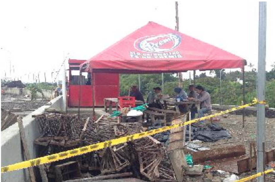
Figura 36. Zona de alimentación obra E401
