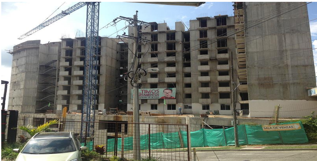
Figura 40. Vista general de la obra E501
