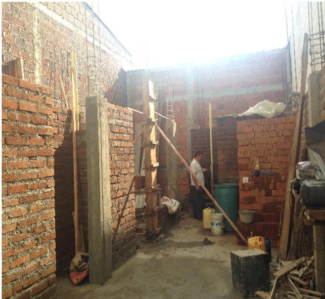
Figura 28. Obra 3. Aspectos de la obra
