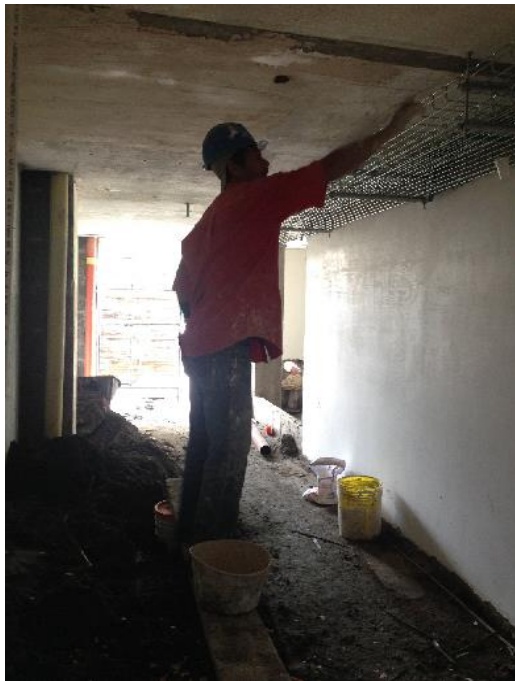
Figura 25. Oscuridad e inestabilidad en la escalera improvisada
