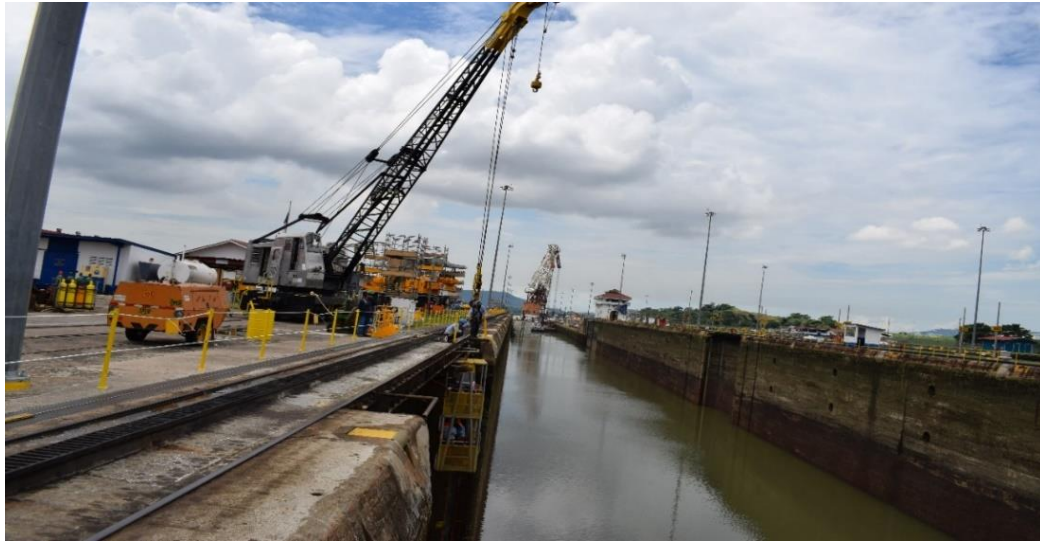
Figura 13: Esclusas de Miraflores en mantenimiento
