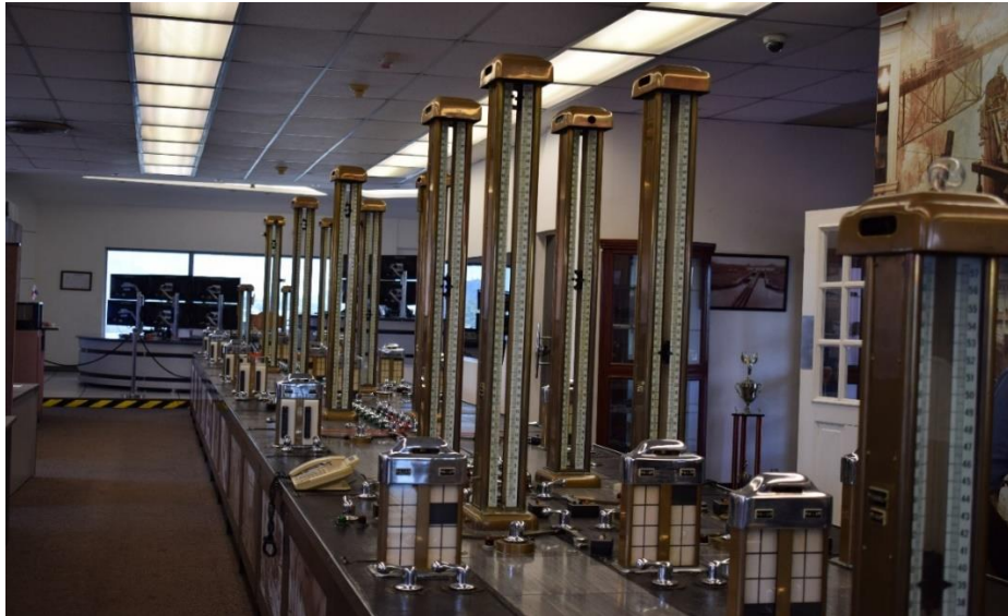
Figura 16: Sistema de control antiguo
