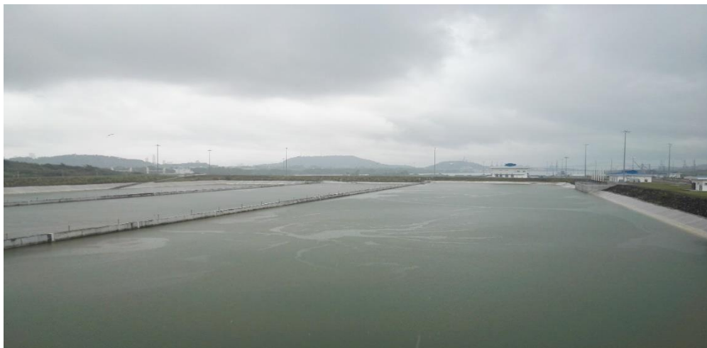
Figura 24: Tinias ahorradoras de agua de esclusas de Cocolí
