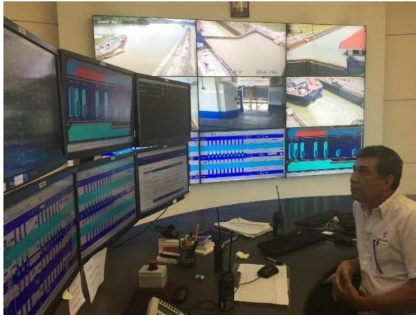
Figura 40. Consolas HMI del Edificio de Control hasta el sensor
