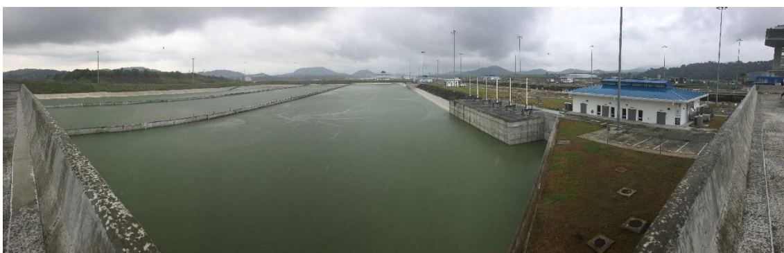
Figura 21. Cámaras de las Esclusas del Canal de Agua Clara
