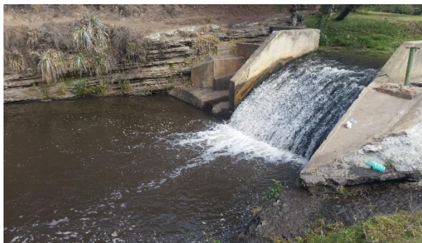
Fotografía 1. Bocatoma del acueducto urbano, Municipio de Ubaté (Cundinamarca).
