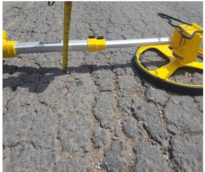
Hundimiento con Piel de cocodrilo
