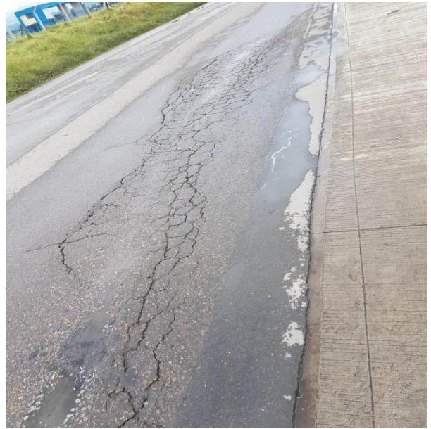
Fisuramiento en bloque
