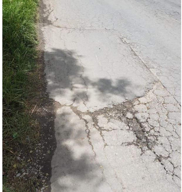
Parqueo con piel de cocodrilo en su inferior aflorando
