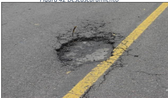
Figura 42 Descascaramiento
