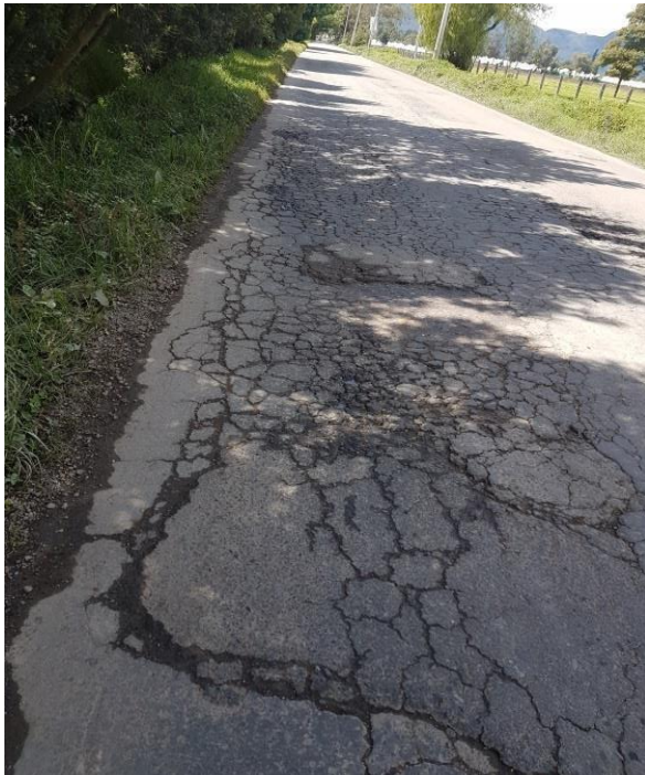
Piel de cocodrilo con desprendimiento de material
