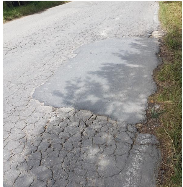
Parqueo con piel de cocodrilo en su inferior aflorando
