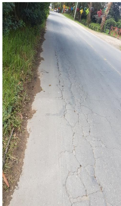
Fisuras de borde, paralelas al eje de la via, con cerca viva
