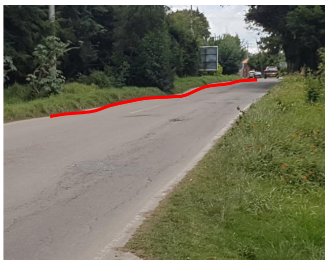
Hundimiento repetitivo
