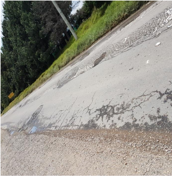
Fisuramiento en bloque
