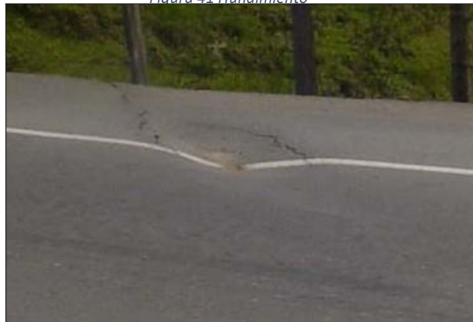
Figura 41 Hundimiento
