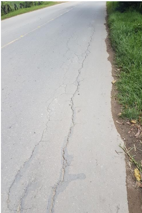
Fisuras de borde, paralelas al eje de la via, con cerca viva
