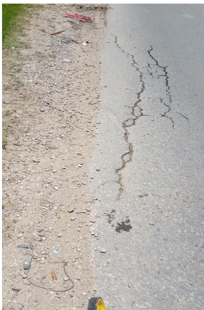
Fisura de borde paralela al eje de la vía
