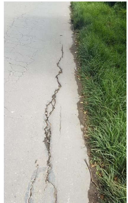
Fisuras de borde, paralelas al eje de la via, con cerca viva
