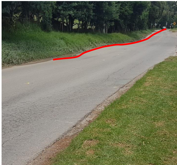
Hundimiento repetitivo
