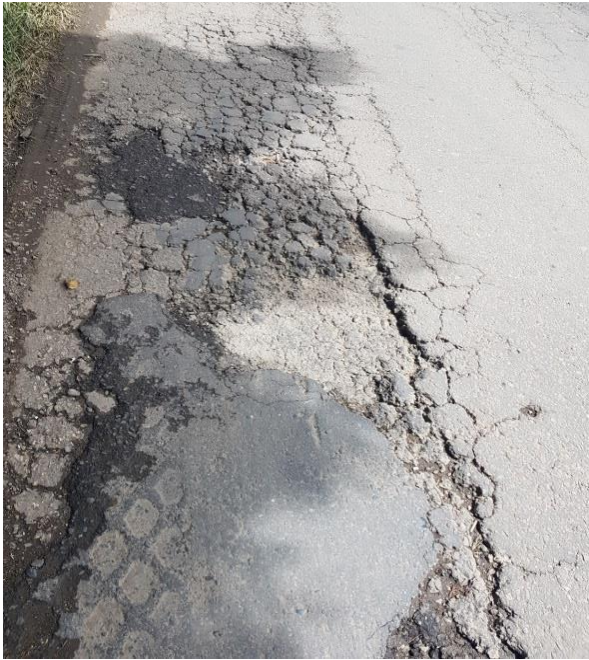
Piel de cocodrilo con desprendimiento de material
