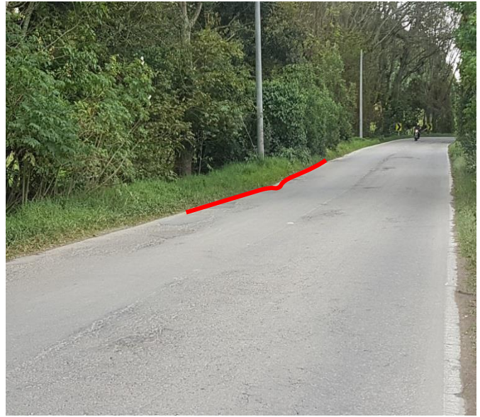
Hundimiento con cerca viva
