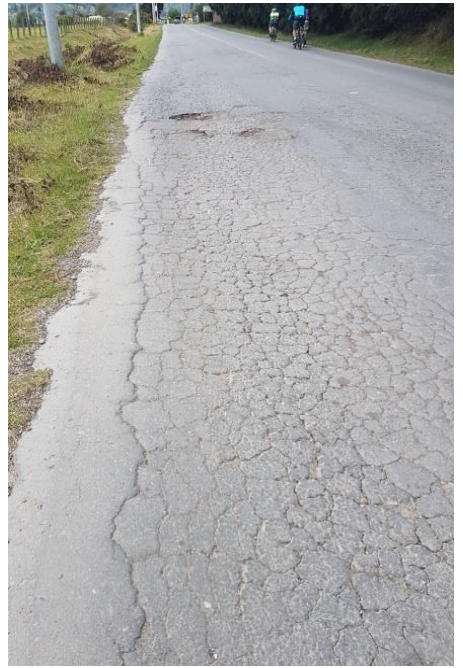
Fisuras de borde con presencia de cerca viva y piel de cocodrilo
