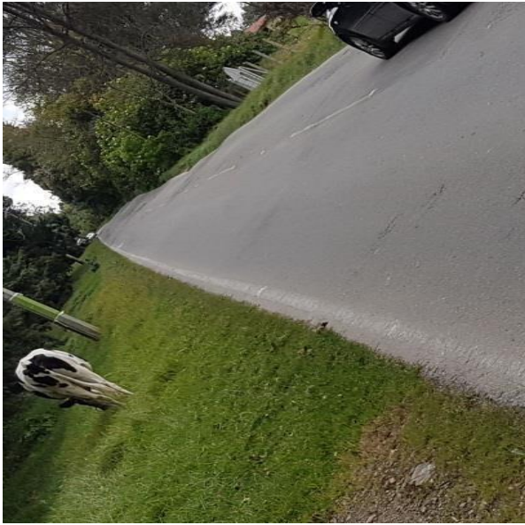
Hundimiento repetitivo
