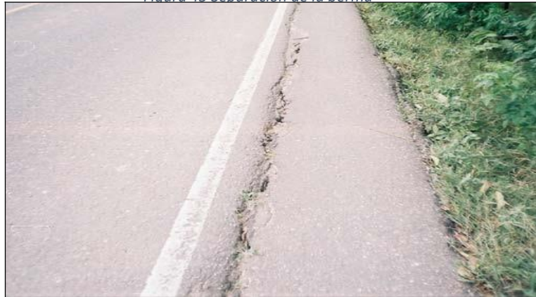
Figura 45 Separación de la berma
