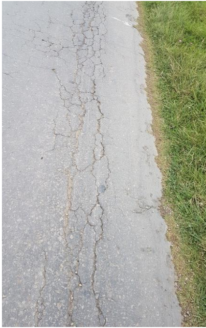
Fisuras de borde con presencia de cerca viva y piel de cocodrilo
