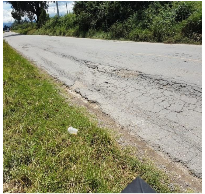
Combinación de patologías, predominando la piel de cocodrilo y el hundimiento
