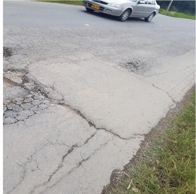
Parqueo con piel de cocodrilo en su inferior Aflorando y fisuras de borde
