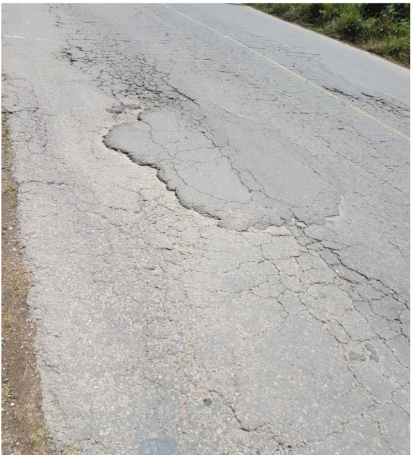
Parqueo con piel de cocodrilo en su inferior
