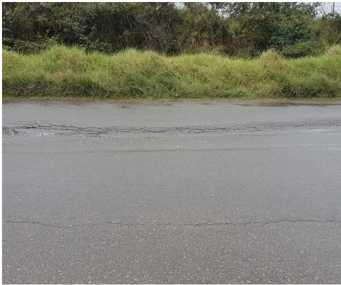
Cerca viva con piel de cocodrilo paralela a la via
