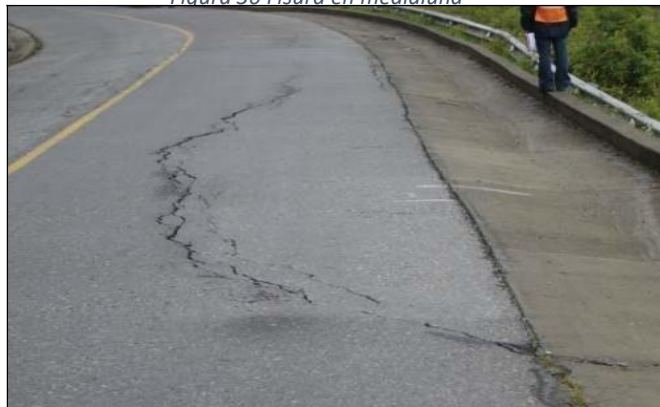
Figura 36 Fisura en medialuna
