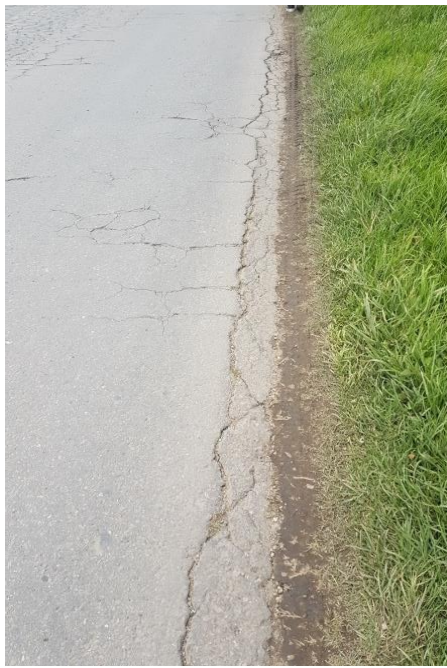
Fisuras de borde con presencia de cerca viva y piel de cocodrilo
