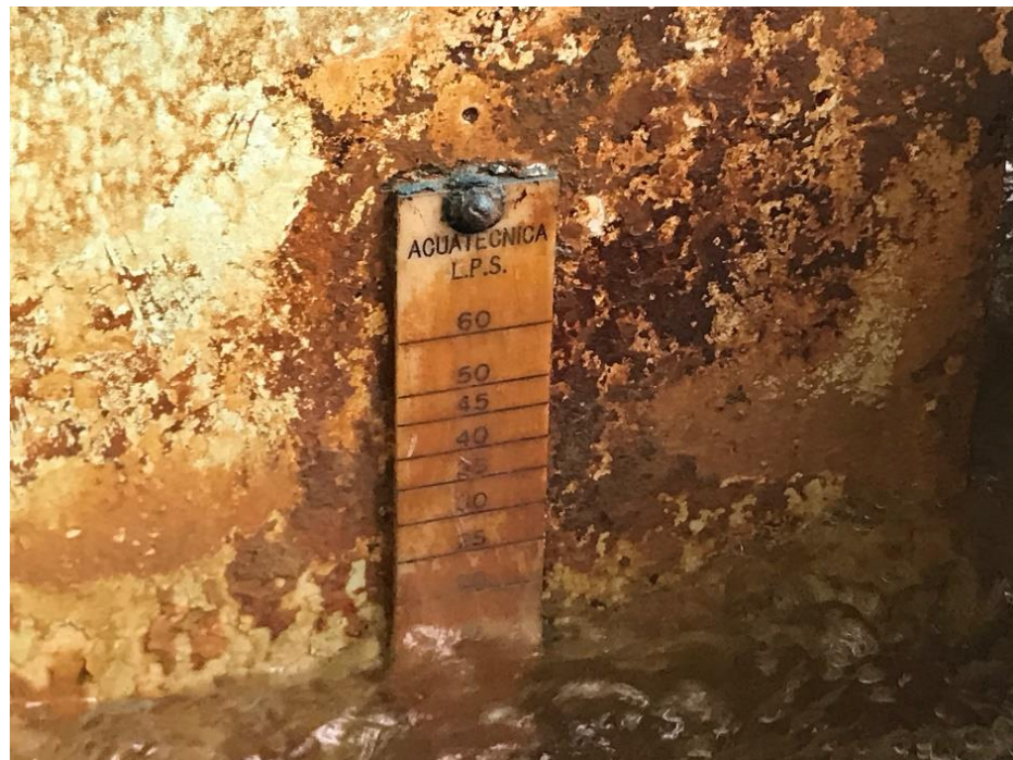
Figura. 4-7. Medición de Caudal – PTAP La Chica.
