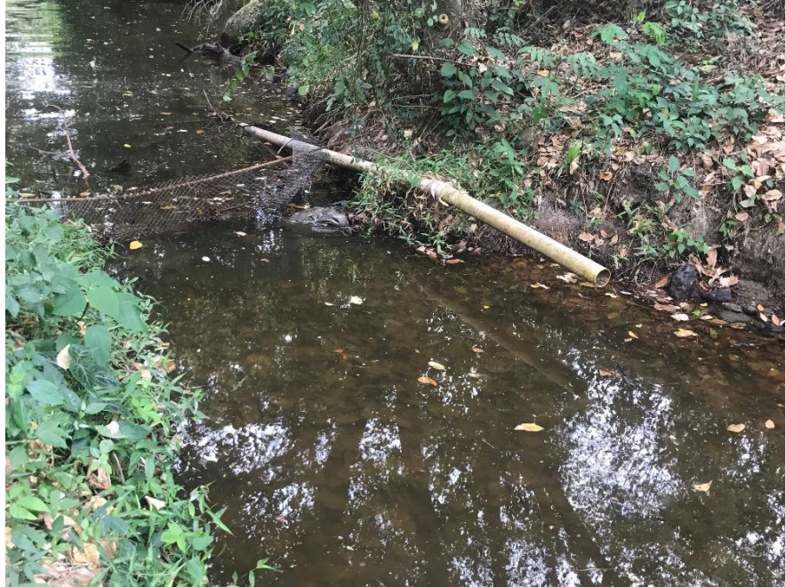
Figura. 4-10. Bocatoma Embalse Mesa de Yeguas.
