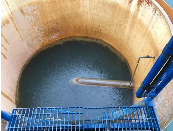
Figura. 4-4. Planta Compacta de Tratamiento de Agua Potable La Chica.
