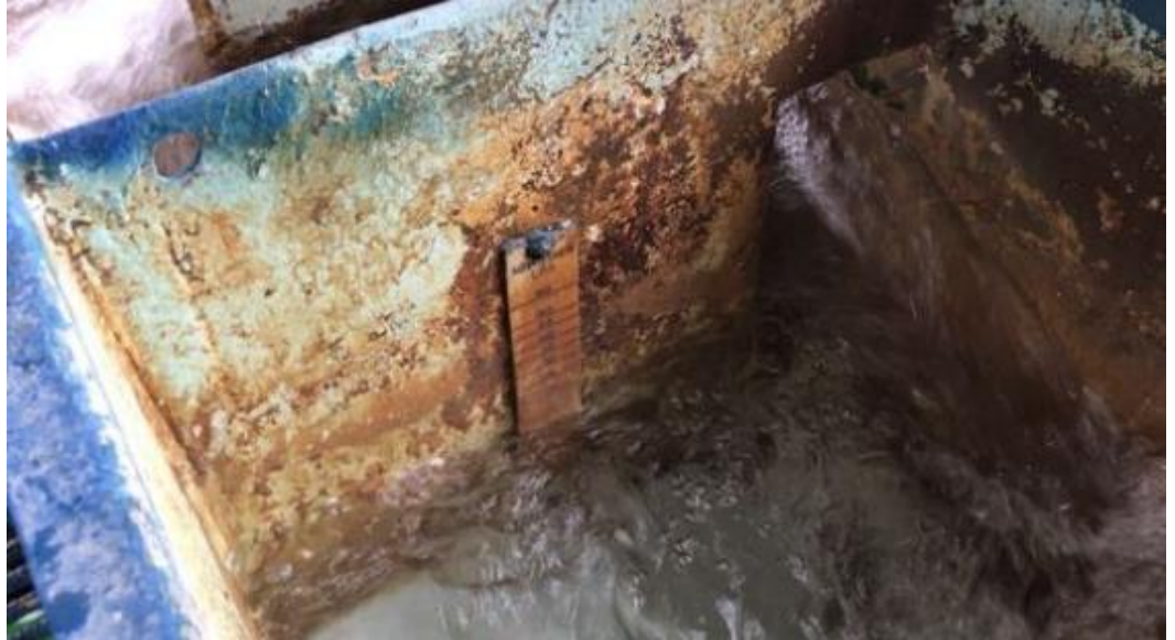
Figura. 4-6. Vertedero Triangular – PTAP La Chica
