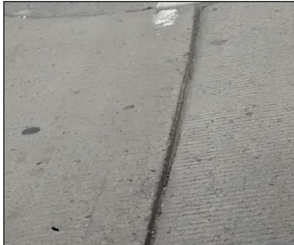
Figura 32. Separación de Juntas Longitudinales (SJ)
