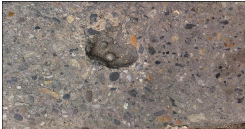
Figura 35. Descascaramiento (DE)
