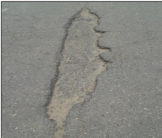
Figura 18. Descascaramiento (DC)
