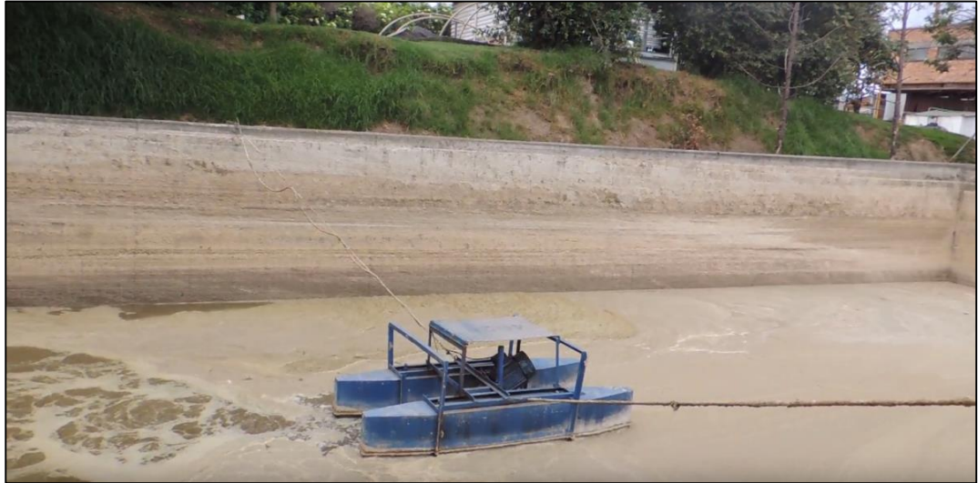
Figura 19. Zonas muertas tanque homogenizador
