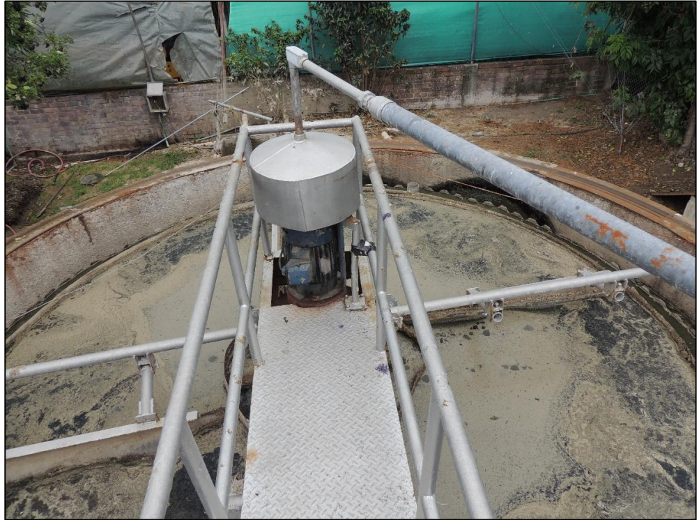
Figura 12. Unidad DAF vista en planta.
