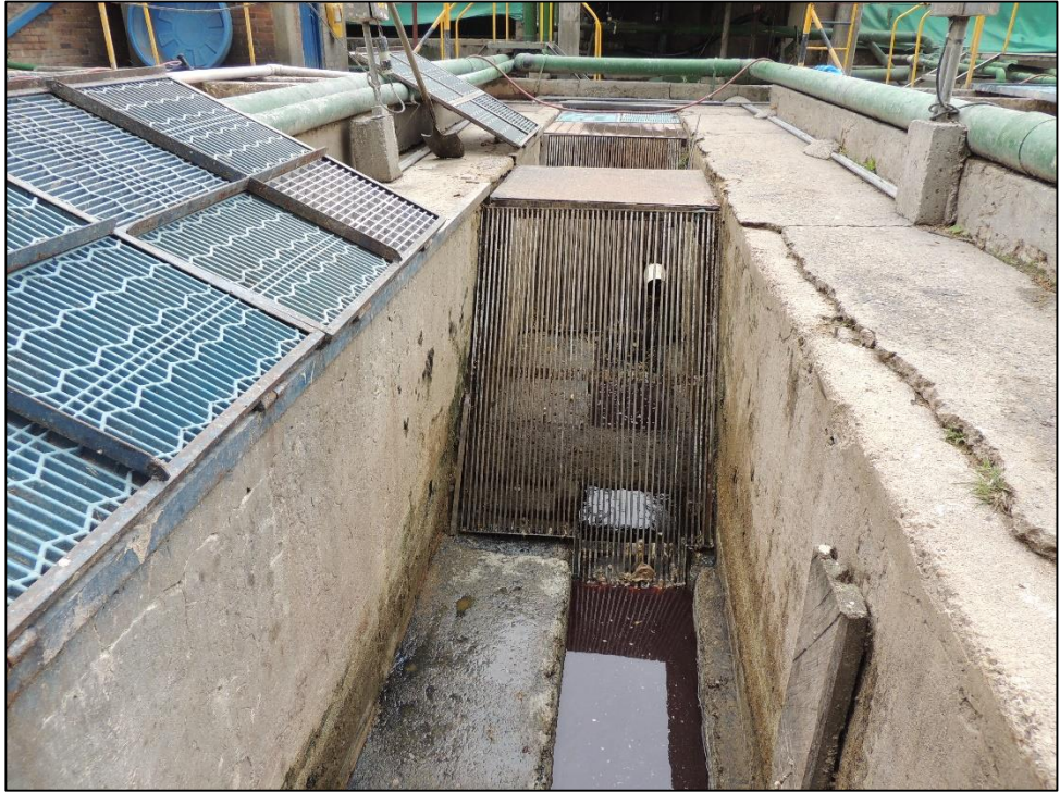
Figura 4. Canal y rejillas
