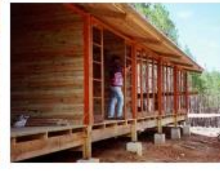
7. Colocação das esquadrias - colocação dos batentes e esquadrias .
