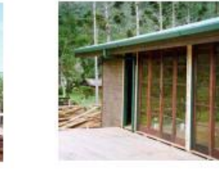
8. Acabamentos - colocação de vidros, calhas e rufos, execução de pintura (stain).
