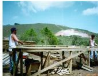
2. Pré-fabricação dos componentes do pórtico - execução sobre bancada, sem gabarito.
