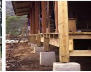
4. Piso – colocação dos barrotes sobre vigas do piso; execução do assoalho.
