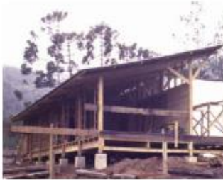
5. Cobertura - colocação das telhas de cimento-amianto e pregação com pregos de telheiro
