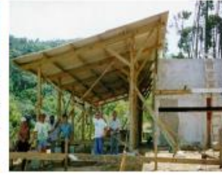
3. Montagem dos pórticos - posicionamento dos pilares do pórtico; verificação de nível prumo, fixação das vigas e mãos francesas.
