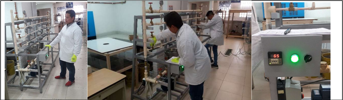
Figura 15. Banco Hidráulico Instalado en Laboratorio de Plantas
