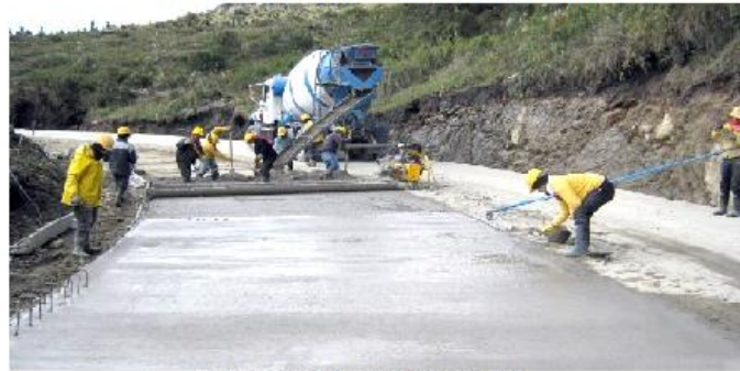
PAVIMENTO DE CONCRETO
