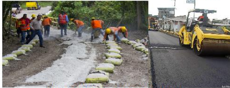
SUELO CEMENTO + CAPA DE RODADURA
