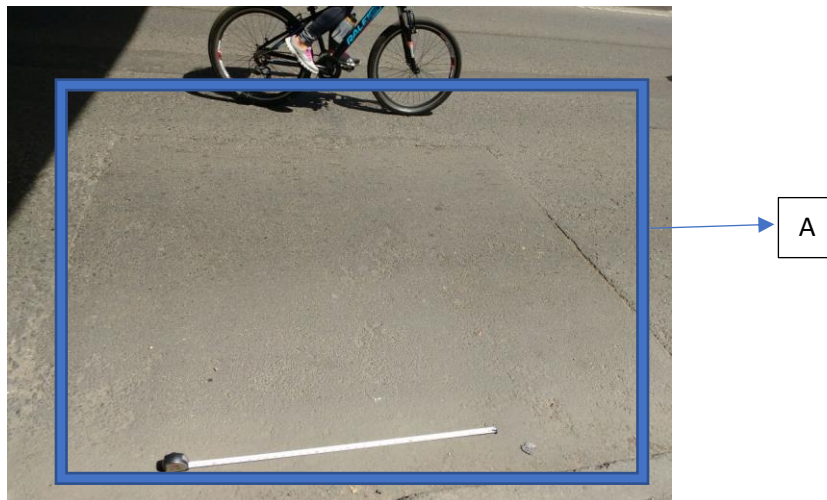
Figura 10: auscultación pavimento flexible
