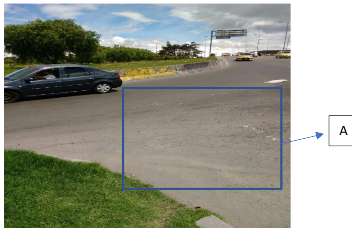
Figura 34: auscultación pavimento flexible.
