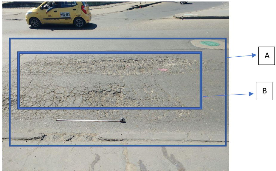
Figura 13: auscultación pavimento flexible
