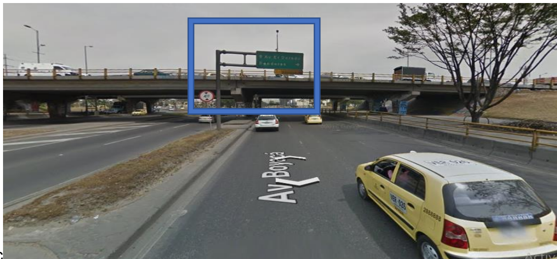
Figura 57: señalización sentido SUR- NORTE.
