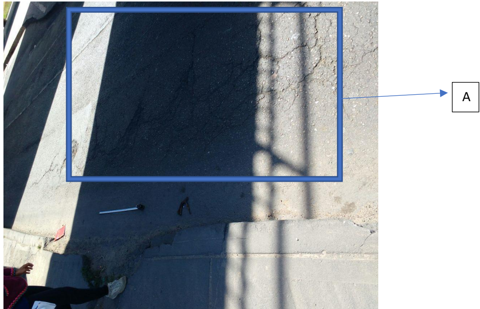
Figura 11: auscultación pavimento flexible
