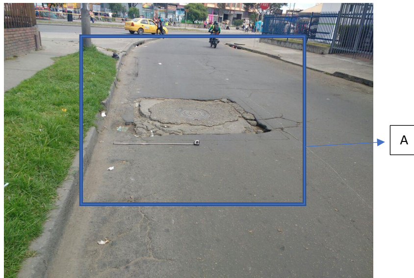
Figura 26: auscultación pavimento flexible.
