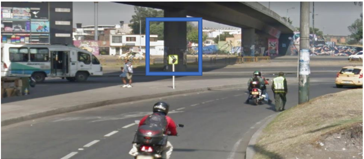
Figura 76: señalización en bifurcación de primera de mayo de este a oeste a avenida Boyacá de sur a norte
