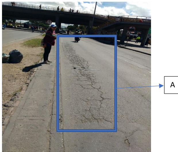
Figura 14: auscultación pavimento flexible
