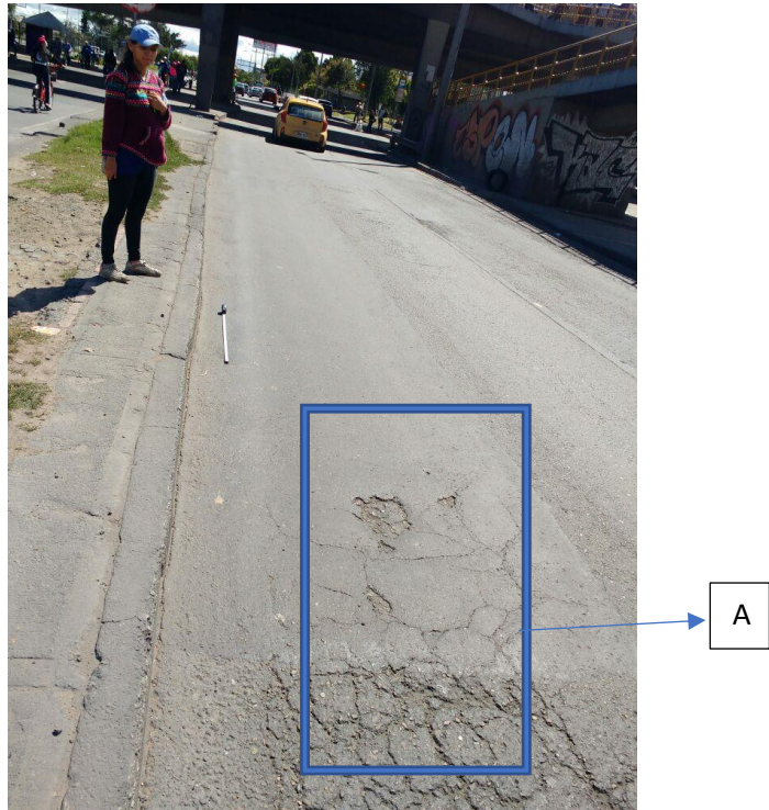
Figura 15: auscultación pavimento flexible
