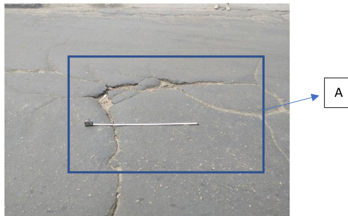
Figura 30: auscultación pavimento flexible.
