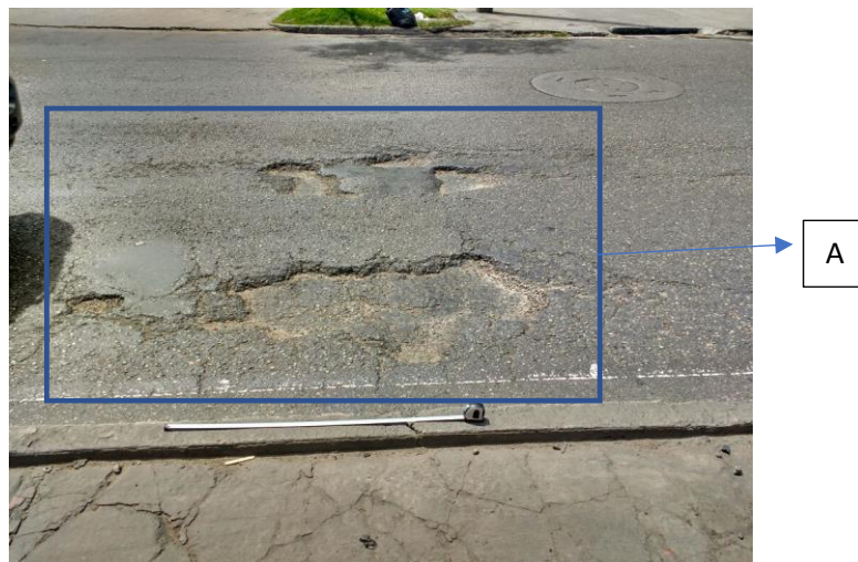
Figura 49: auscultación pavimento flexible
