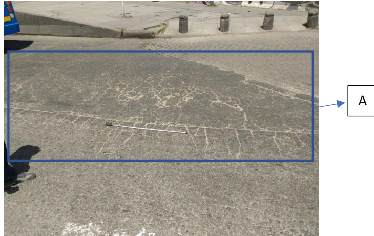
Figura 44: auscultación pavimento flexible
