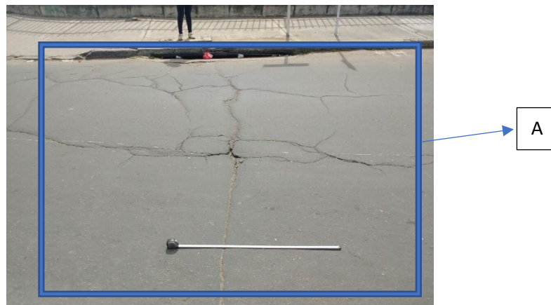
Figura 23: auscultación pavimento flexible
