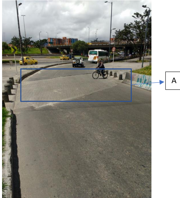
Figura 42: auscultación pavimento flexible
