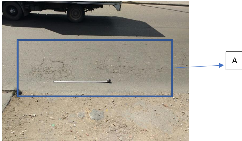
Figura 20: auscultación pavimento flexible
