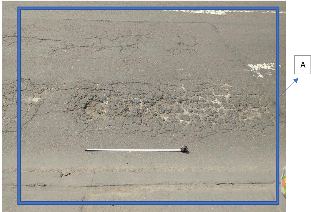
Figura 24: auscultación pavimento flexible
