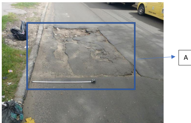
Figura 28: auscultación pavimento flexible.
