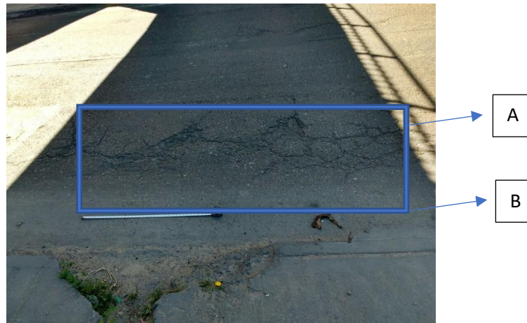
Figura 16: auscultación pavimento flexible
