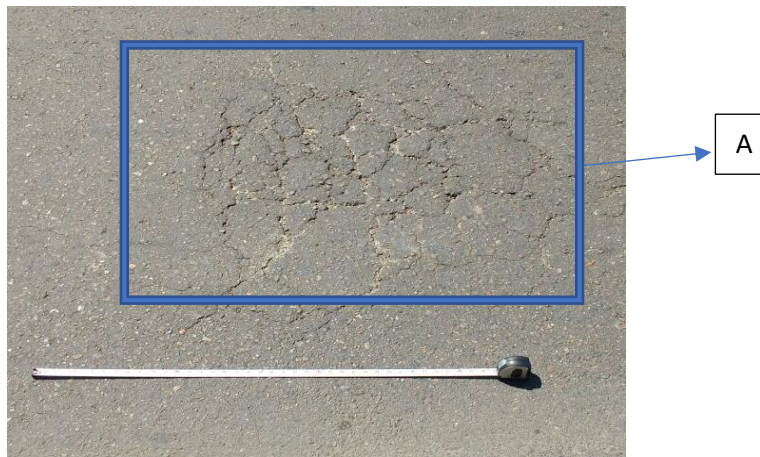
Figura 19: auscultación pavimento flexible
