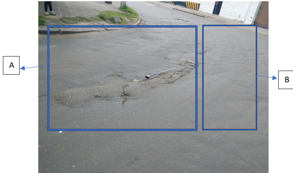
Figura 27: auscultación pavimento flexible.
