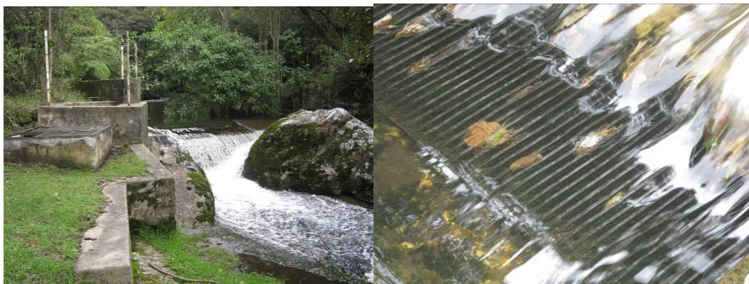
Figura 1 Fuente de Captación y Estructura de Captación PTAP Sibaté
