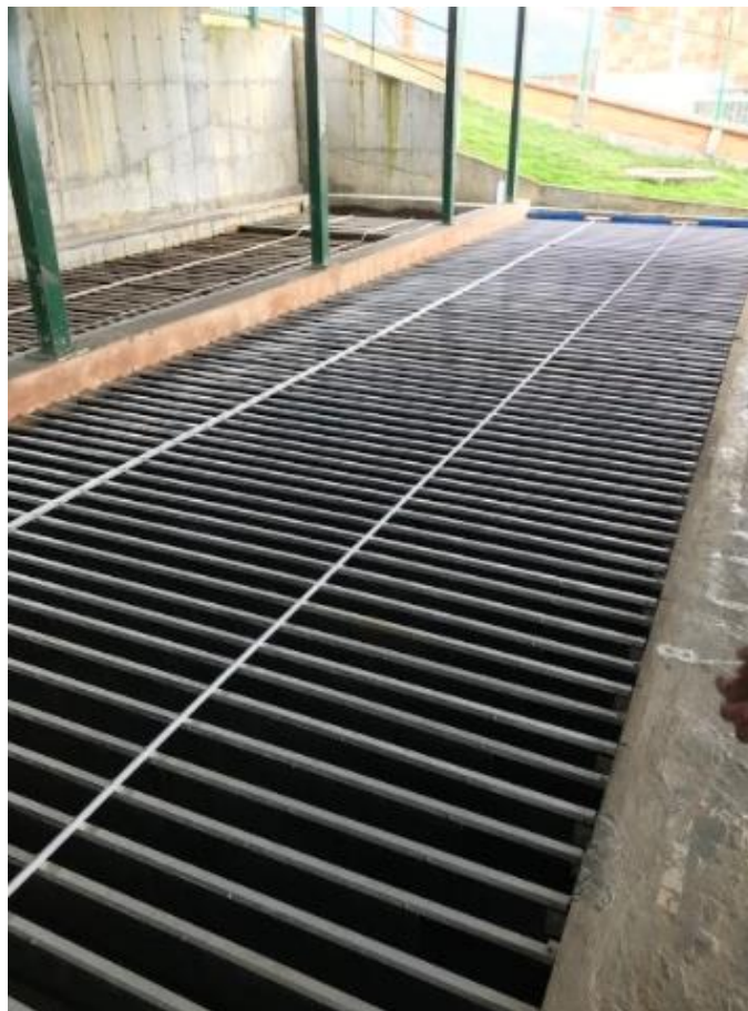
Ilustración 6. Floculadores PTAP Municipio de Sibaté
