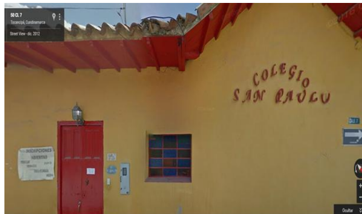
Figura 5 Fachada del Colegio San Paulo Tocancipá SAS
