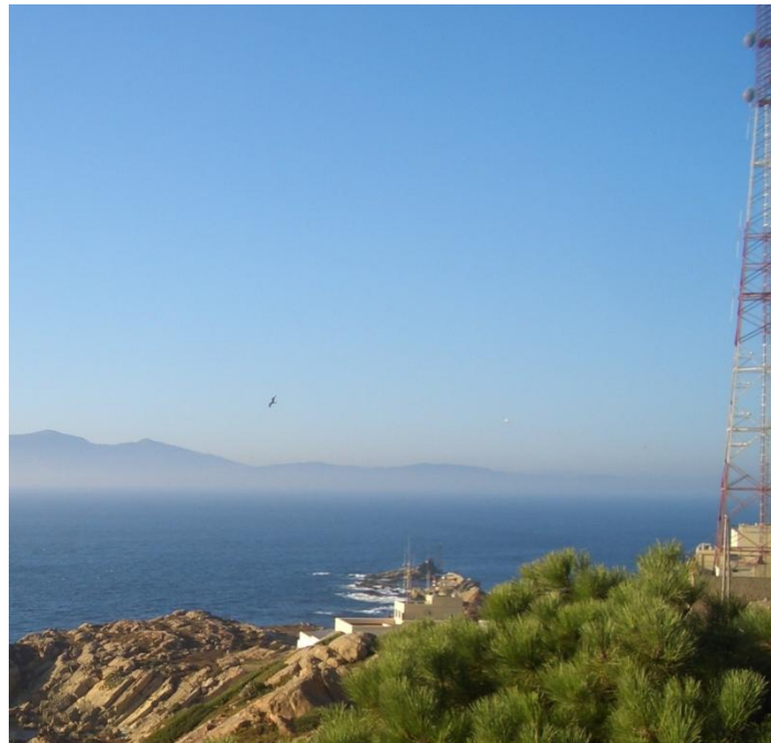
Foto 9: Infraestructura de telecomunicación en Punta Cires. Fuente: www.pisaprados.com
