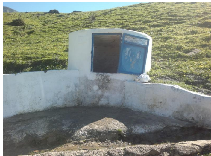
Foto 11: Pozo para extracción de agua subterránea. Fuente: Elaboración Propia.
