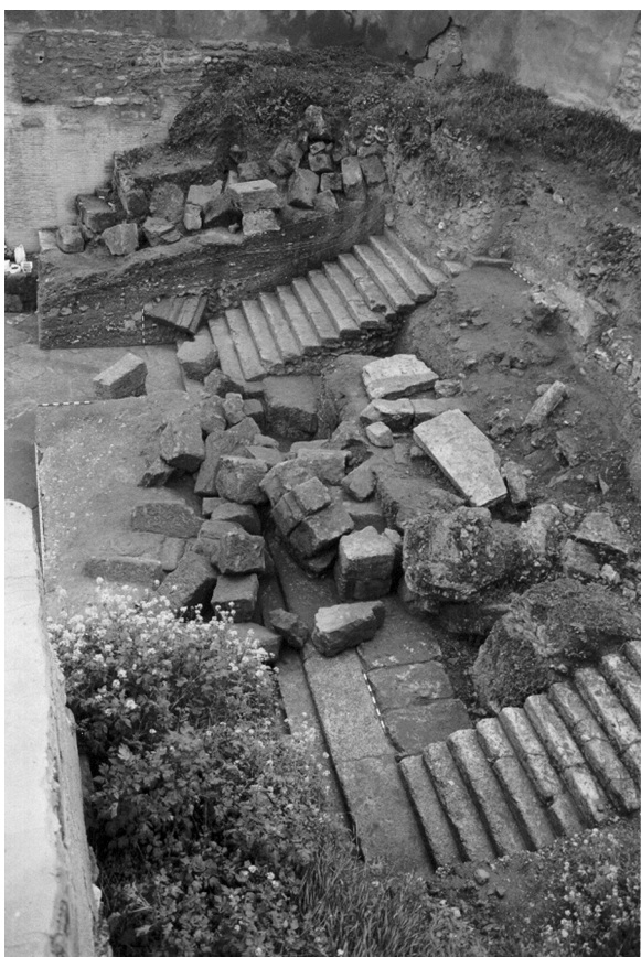
Lám. 16 a y b: Desplome y colmataciones en rampa del muro de contención entre la terraza media oriental y la superior en el flanco E del teatro romano de Córdoba (Fotos A. Ventura),
