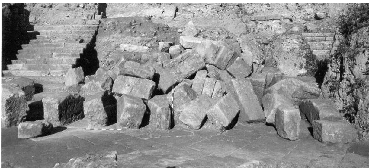
Lám. 16 a y b: Desplome y colmataciones en rampa del muro de contención entre la terraza media oriental y la superior en el flanco E del teatro romano de Córdoba (Fotos A. Ventura),
