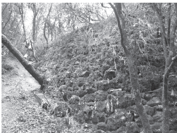
Lám. 1: Talud artificial para contener la presión del pozo.
