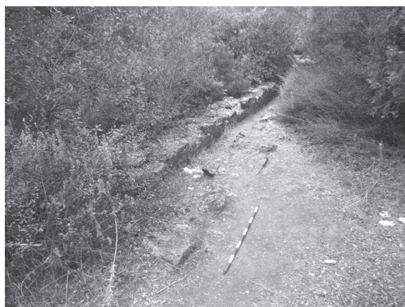
Lám. 7: Vista del canal que, por la parte inferior del pozo, formaba parte de las estructuras superiores del molino del Molinillo.
