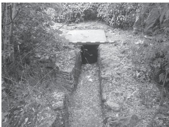
Lám. 8: Desagüe del canal, al que iba el agua de un gran depósito conservado a poca distancia y que, subsidiariamente, servía para recoger el agua del deshielo del pozo.
