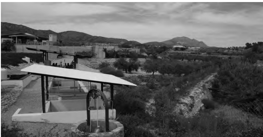
Figura 6. Estación de Aguas Residuales (EDAR) de Barinas.
