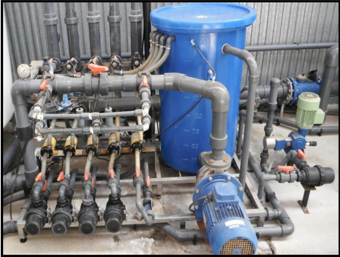
Figura 15. Cabezal de riego usado para abastecer el invernadero del ensayo.
