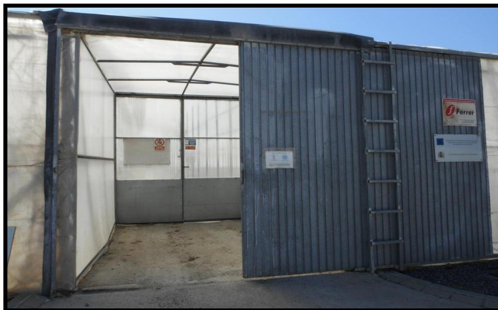
Figura 10. Sistema de doble puerta a la entrada del invernadero.
