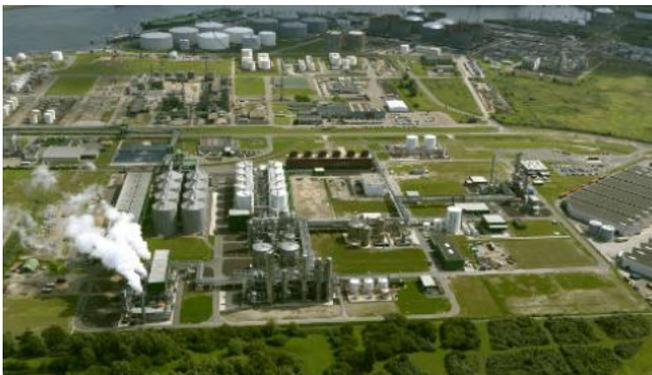
Figura 6. Vista aérea de la planta de bioetanol de *Abengoa Bioenergy* en Rotterdam, Holanda, con una producción de bioetanol de 480M l obtenidos a partir de cereales.
