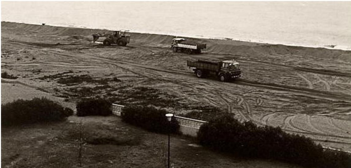
**Uso de camiones y palas mecánicas para la extracción de áridos.
