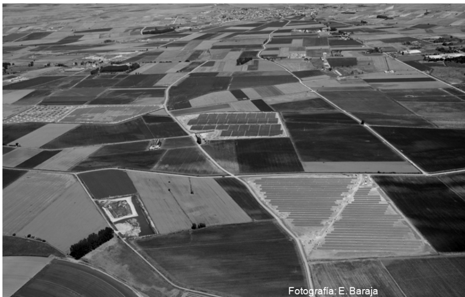
Fotografía 3. Instalación solar fotovoltaica sobre parcelas agrícolas de regadío.
