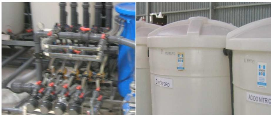
**Figura 13. Instalación de fertirriego: Cabezal de cuatro válvulas mezcladoras y recipientes de 1000 litros de capacidad para la preparación de los componentes de la solución nutritiva.**
