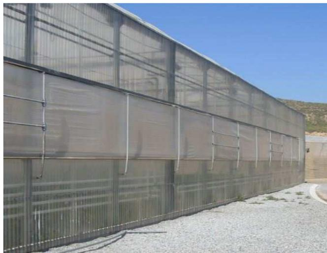
**Figura 21. Detalle de la ventilación lateral del invernadero U11.**
