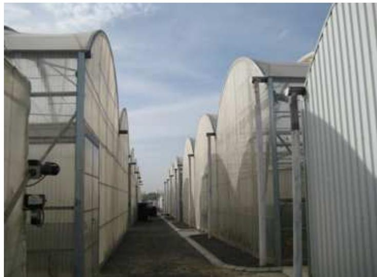
*Figura 11. Detalle de las canaletas de recogida de aguas de lluvia.*
