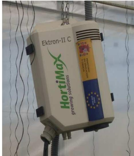
**Figura 16:** Detalle de sensor en el interior del invernadero de temperatura, Humedad relativa y CO<sub>2</sub>.
