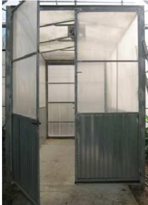
*Figura 22. Detalle de la puerta de doble cierre instalada en los invernaderos.*
