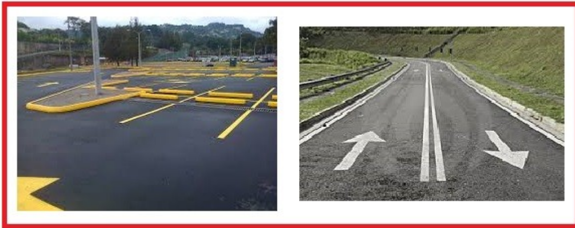
Imagen 8. Demarcación vial sobre pavimento de concreto
