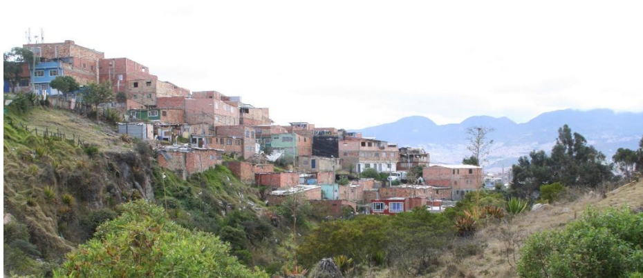
Imagen 3. Imagen de construcción sobre laderas no estabilizadas en canteras.
