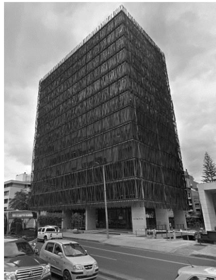
Figura 6. Edificio Terpel Fuente: Elaboración Propia
