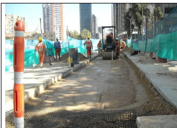
Foto No. 3: INSTALACIÓN GEOMALLA BIAIXIAL GRANULARES
