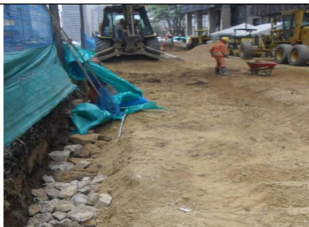
Foto No. 2: MEJORAMIENTO DE LA SUBRASANTE CON RAJÓN
