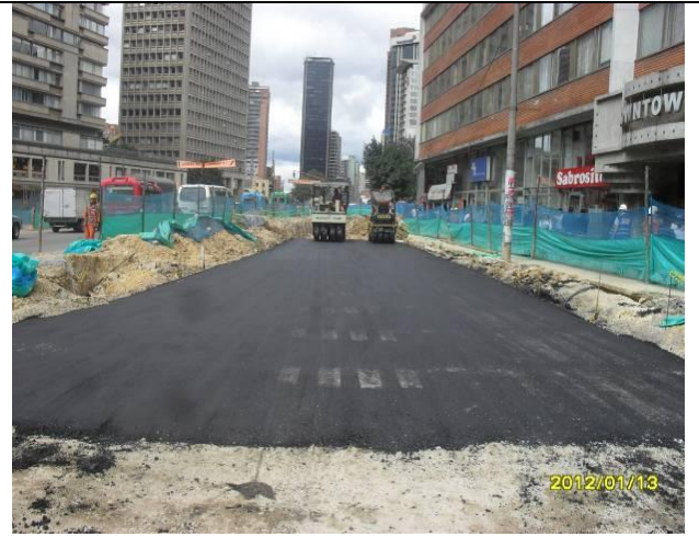
Foto No. 8: COMPACTACIÓN 1° CAPA MD-20
