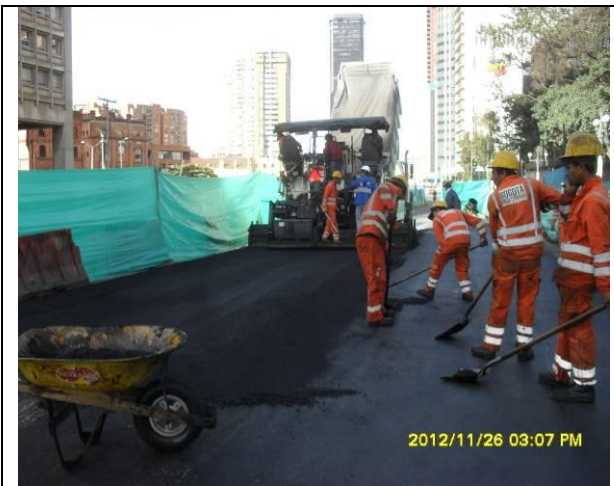
Foto No. 11: EXTENDIDA CAPA RODADURA EN MD-12
