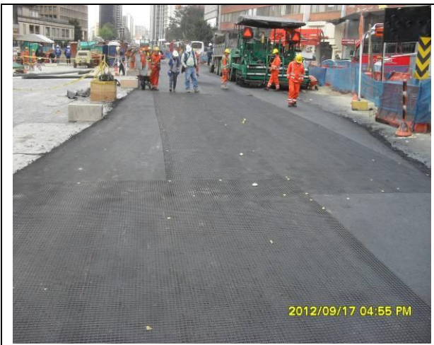
Foto No. 9: INSTALACIÓN GEOMALLA F.V. EN CAPA MD-20
