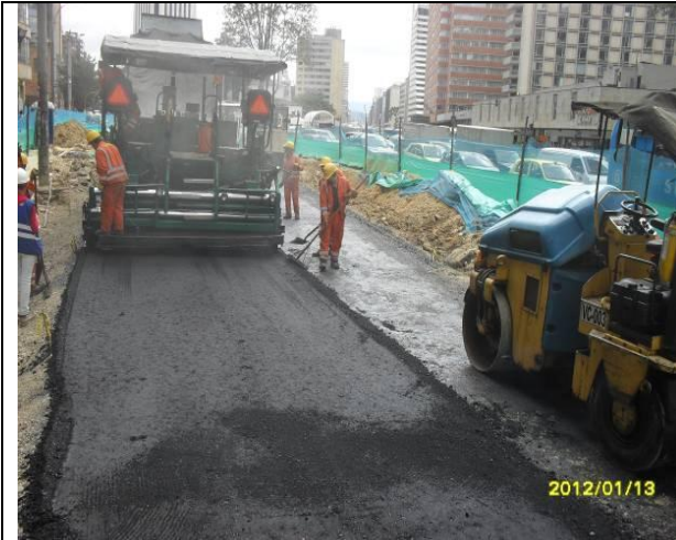
Foto No. 7: MEZCLA ASFALTICA MD-20 1° CAPA
