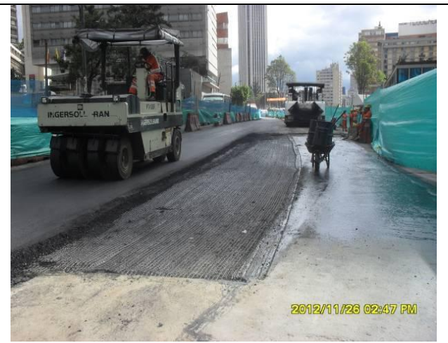
Foto No. 10: COLOCACIÓN MD-20 SOBRE GEOMALLA F.V.
