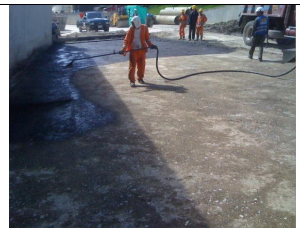
Foto No. 6: IMPRIMACIÓN CON CRLS SOBRE CAPA DE BG-A
