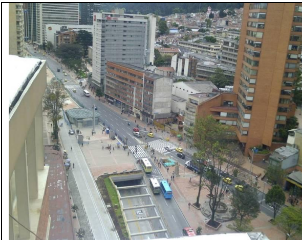
Foto No. 17 - Carreras 10 y 7 con Calle 27: Inicio pavimento flexible sobre Estación Museo Nacional
