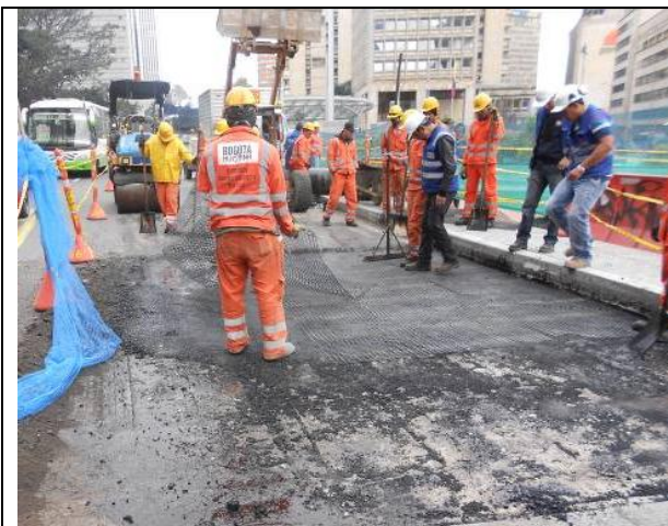
Foto No. 13: INSTALACIÓN GEOMALLA BIAIXIAL SOBRE LOSA TRANSICIÓN
