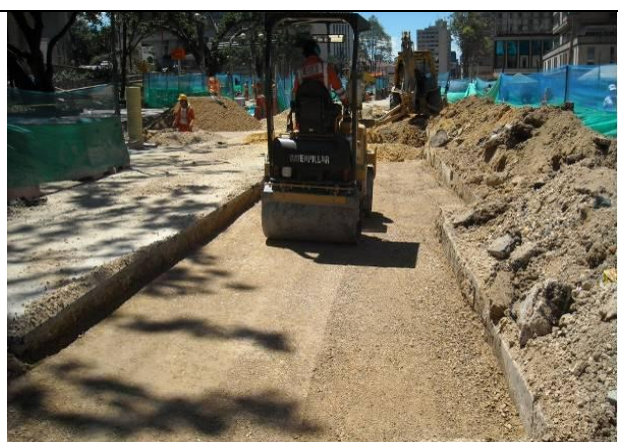
Foto No. 4: COMPACTACIÓN SBG-A SOBRE GEOMALLA
