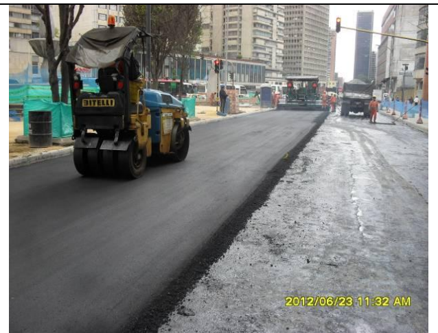
Foto No. 12: COMPACTACIÓN CAPA RODADURA MD-12
