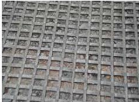
Figura 3. Geomalla Biaxial Fibra Vidrio capas asfálticas (PAVCO)
