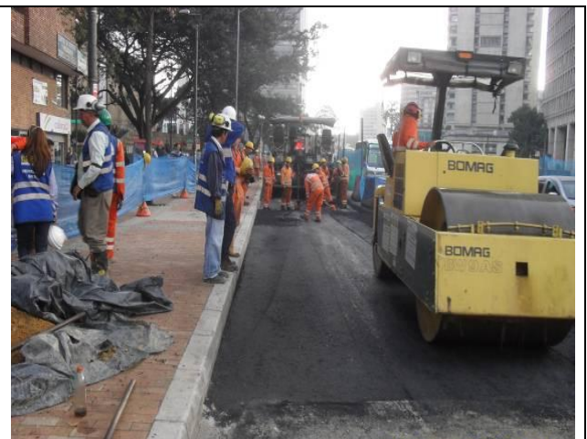
Foto No. 14: COMPACTACIÓN CAPA DE RODADURA MEZCLA MD-12, SOBRE LOSA DE TRANSICIÓN CON GEOMALLA F.V.
