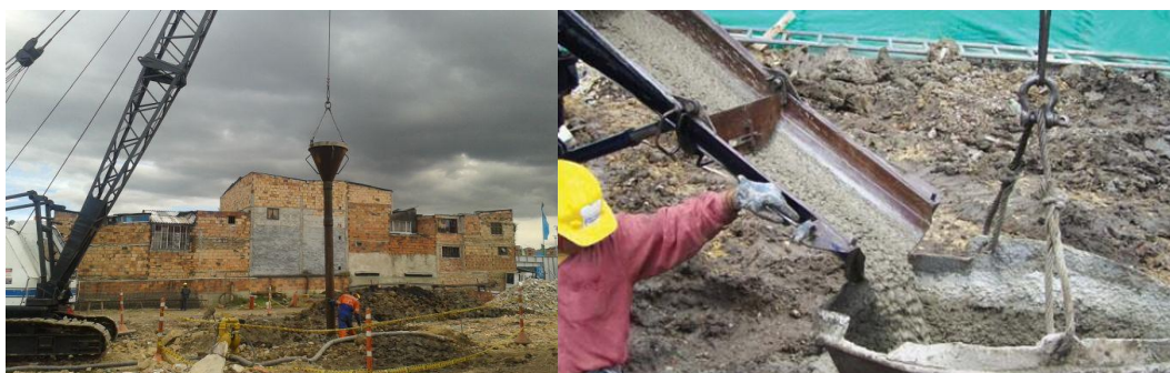
Figura 6: Izado de tubo Tremie y Tolva, y vaciado de concreto.
